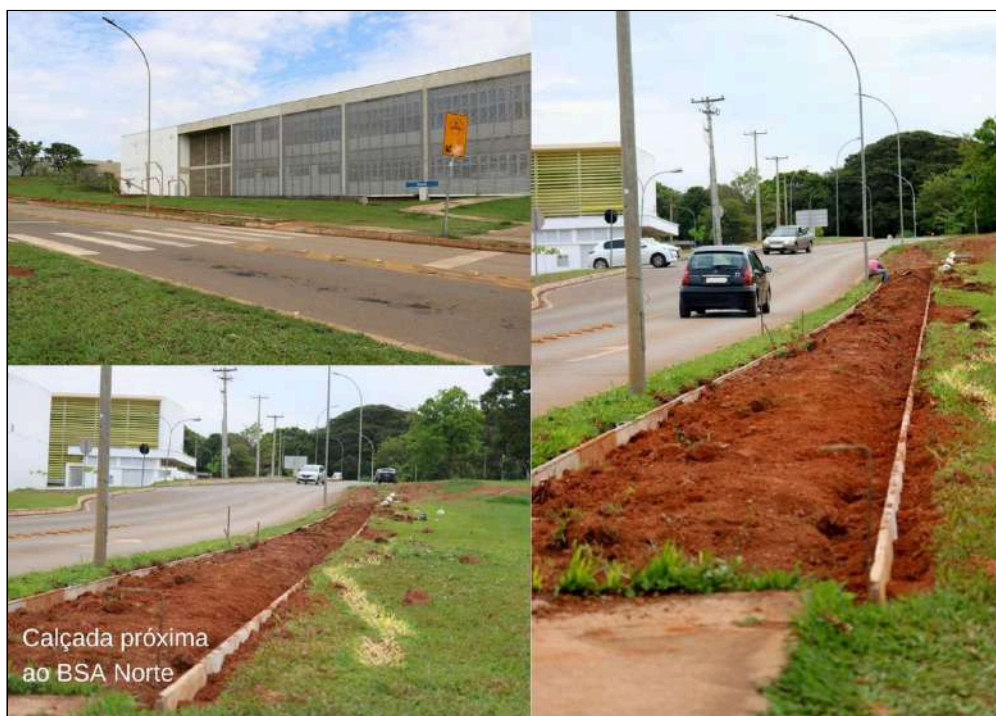
Construção de calçada ao lado do BSAN
